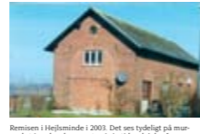
Remisen i Hejlsminde i 2003. Det ses tydeligt på murværket i væggen, hvor porten var ind til sad. I den længere bygningen primært som beboelse, der er indrettet i de lokaler, hvor lokomotivpersonalet overnattede. Eieren og beboeren hedder Lilly Hansen (2007), og hun har boet der siden 1949, og for den tid fungerede hun ved sydbanerne i Hejlsminde som rengøringsdame.
