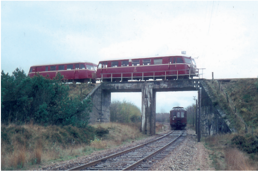
Nord for Grindsted krydsede Trolldhebanens og DSB's hovedspor ude af niveau. På Hans Jørn Fredbergs billede fra 1967 er et skinnebustog til Trolldhede på vej over et DSB-tog, fremført af en MO-vogn, mod Brande. Som det ses, var der fra starten gjort klar til, at statsbanen kunne udvides til dobbeltspor.
